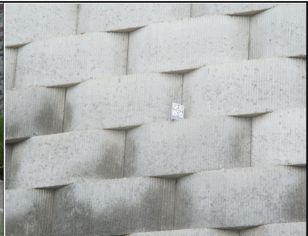
STA.7+560~7+834 계측기 설치 상태(서울방향)
