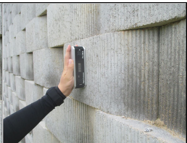
STA.7+560~7+834 옹벽 기울기 측정(서울방향)
