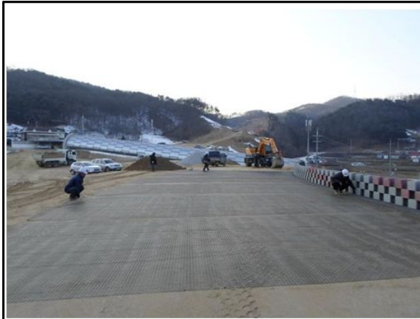
STA.7+560~7+834 그리드 길이 측정(서울방향)
