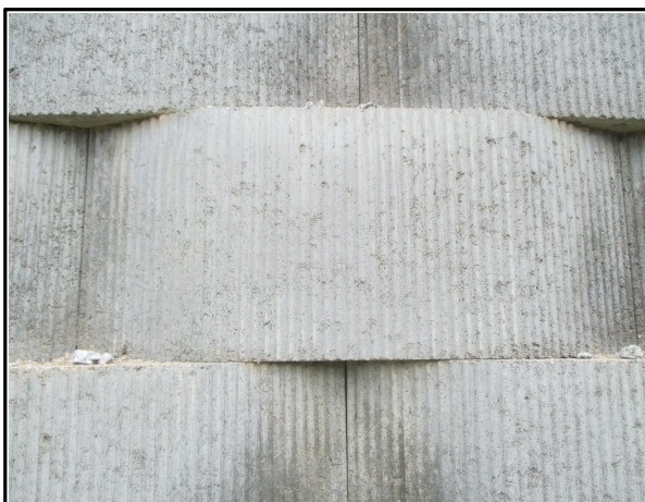
STA.7+560~7+834 옹벽 시공 상태(서울방향)
