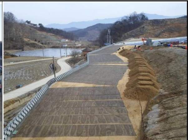
STA.7+560~7+834 지오토크리드 설치 상태(서울방향)
