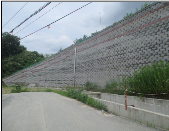
STA.7+560~7+834 옹벽 전경(서울방향)
